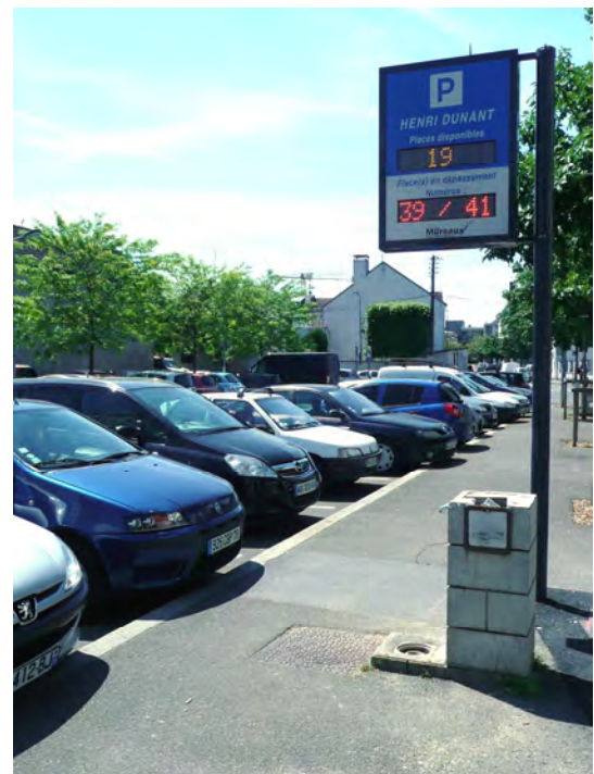
Les Mureaux : Place H. Dunant équipée de plots de détection et d'un panneau pédagogique.
