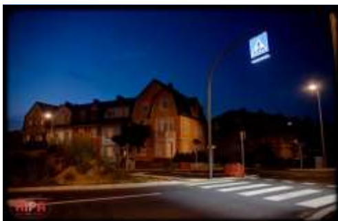
Remplacement des sources lumineuse NAV / NAV-T par des barres à LED's
